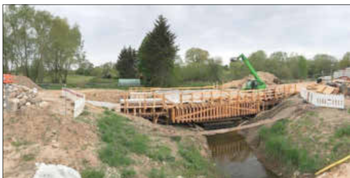
Neubau der Brücke über den Reppeliner Bach
