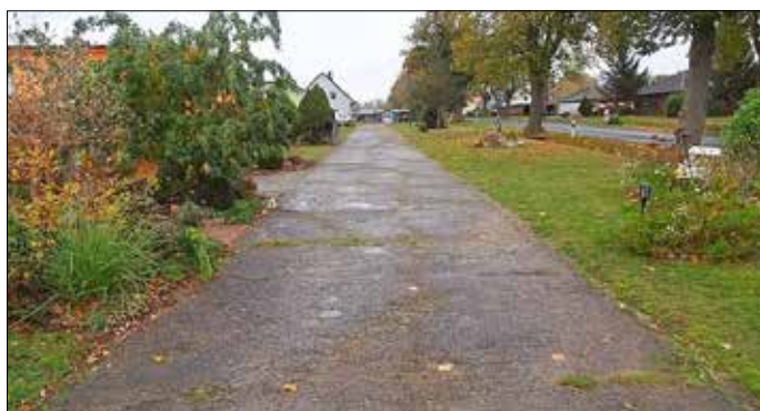
Ausgangssituation vor Baubeginn
