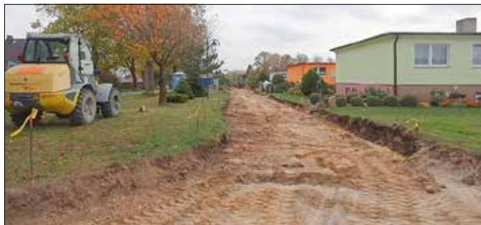
Abbrucharbeiten der alten Betonfahrbahn
